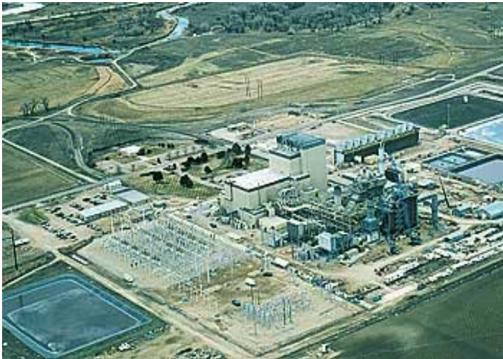
Fort Saint-Vrain, USA 300 MWe 1976-89
