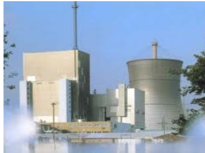
THTR, Niemcy 300 MWe 1986-89
