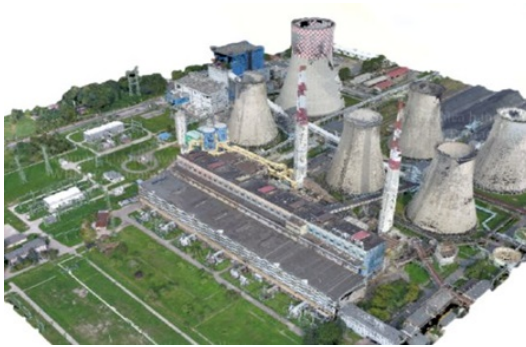
Rys. 18.6. Chmura punktów oraz projekcja 3D części elektrowni Łagisza
